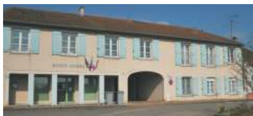
5 logements 4 rue de la Bergerie à Rugy
